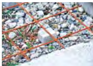
การจะเอาปูนถมให้หนา ต้องใช้ตะแกรงเหล็กเส้นวางเพื่อให้เกิดความแข็งแรง โดยจะวางก่อนหินก่อนวางตะแกรงลวด
