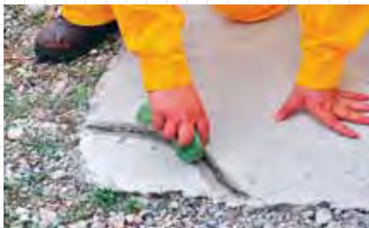
ใช้ฟองน้ำชุบน้ำเช็ดพื้นผิวตรงรอยตัดตัว V
