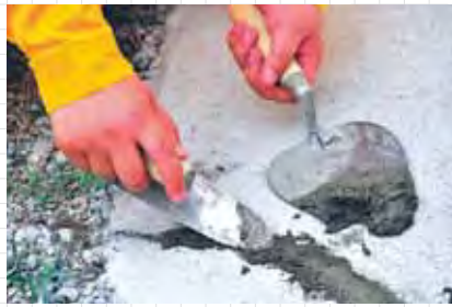
จากรูป จะเห็นว่าปูนฉาบล้นออกมา ให้ใช้ปลายเกรียง กดลงเบาๆ ปูนจะได้อัดลงร่องแน่นขึ้น
