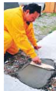
ใช้เกรียงไม้ กดปาดปูนให้เรียบเสมอกับพื้น เกรียงจะต้องไม่ลอยจากพื้นผิวขณะปาด จะทำให้พื้นผิวที่เรียบร้อยสวยงาม
