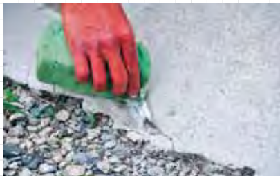
จากนั้นทากาวสำหรับปูนฉาบทับลงไป กาวจะซึมเข้าสู่พื้นผิวรอยตัดรูปตัว V พอทากาวแห้งแล้วค่อยฉาบปูน จะช่วยให้เกาะติดกันมากขึ้น
