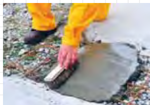
ใช้แปรงหรือไม้กวาดลูบบนผิวหน้าปูนเบาๆ เพื่อให้เกิดรอยแตกหรือเป็นตุ่มกันลื่นเช่นเดียวกับพื้นทางเดินรถที่มีอยู่เดิม วิธีนี้เหมาะกับผู้ที่ไม่เคยทำมาก่อน
