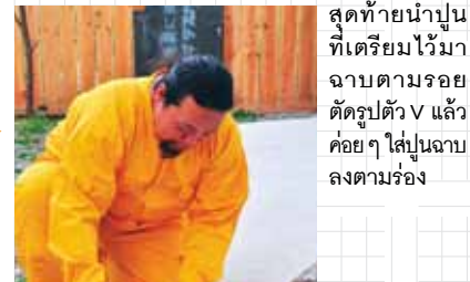
เมื่อตัดเป็นรูปตัว V แล้ว ต้องทำความสะอาดเศษคอนกรีตออกให้หมด ถ้ามีเศษหลงเหลืออยู่ จะทำให้ฉาบปูนไม่ติดดี
