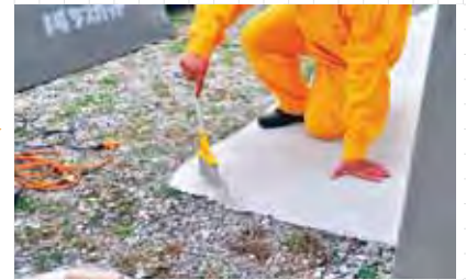
เมื่อตัดเป็นรูปตัว V แล้ว ต้องทำความสะอาดเศษคอนกรีตออกให้หมด ถ้ามีเศษหลงเหลืออยู่ จะทำให้ฉาบปูนไม่ติดดี
