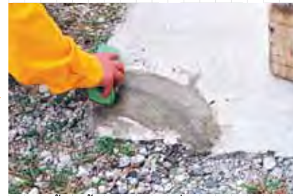
เอาฟองน้ำชุบน้ำมาเช็ดเศษปูนที่กระจายอยู่ให้สะอาด
