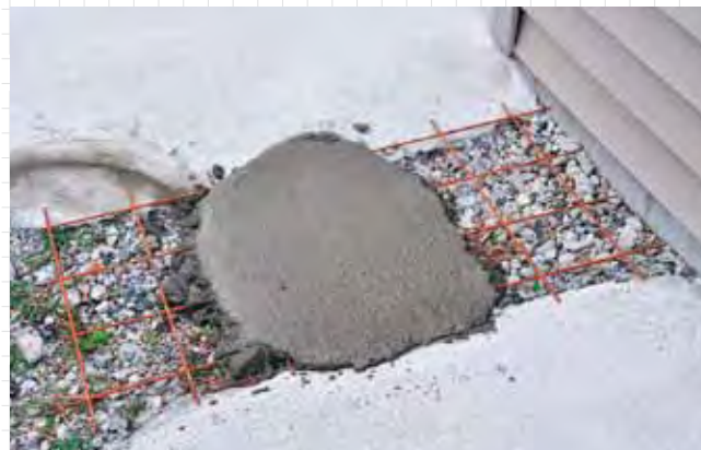
นี่เป็นการทดลอง จึงไม่ได้เตรียมปูนมาเยอะที่จะถมทางเดินรถให้เต็ม โดยหลักการแล้วจะเป็นรูปแบบนี้ แต่ควรใช้ปูนในปริมาณที่เพียงพอ
