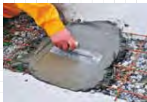
เมื่อเรียบพอประมาณแล้ว ใช้เกรียงเหล็กปาดให้เรียบสวยอีกครั้งหนึ่ง เกรียงเหล็กเมื่อเทียบกับเกรียงไม้แล้ว จะให้พื้นแฉวาวและเรียบเนียนกว่ามาก
